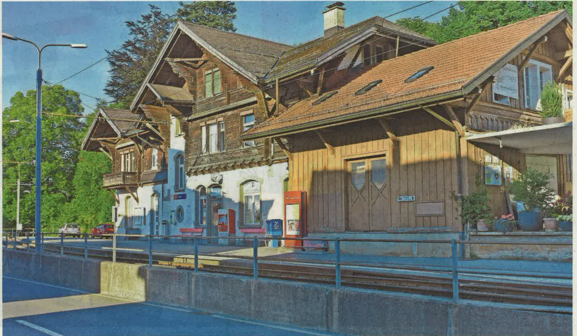
Die Appenzeller Bahnen wollen den Bahnhof Trogen abreißen und durch einen Neubau ersetzen. Gegen das Projekt gibt es Widerstand.
